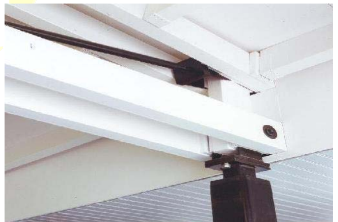
Combinatie's van staal & houten ligger m.b.v. de LF-techniek
