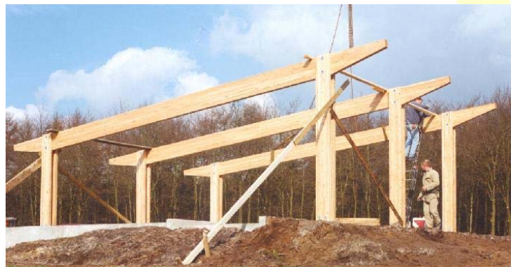
portaal spant met dubbele kolom + ingeklemde ligger
